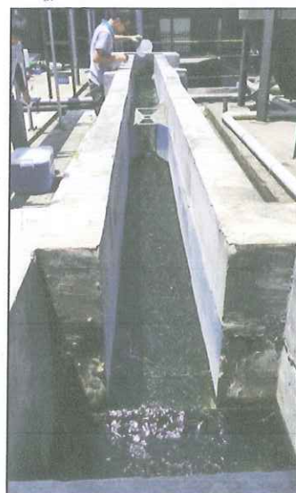
废水处理 after 采样口
